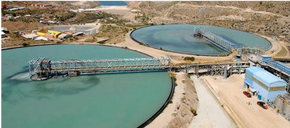
Ilustración 17. Proceso de espesamiento y filtrado. Fuente: [29]
