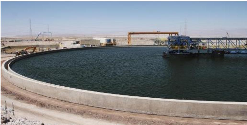
Figura. Espesador. Fuente: Revista Energiminas.
