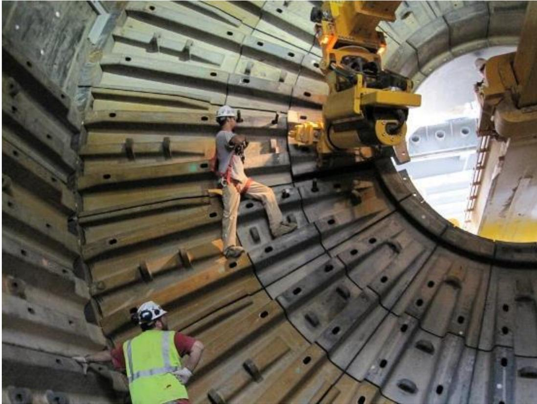
Figura. Revestimiento de molino. Fuente: Elecmetal.
