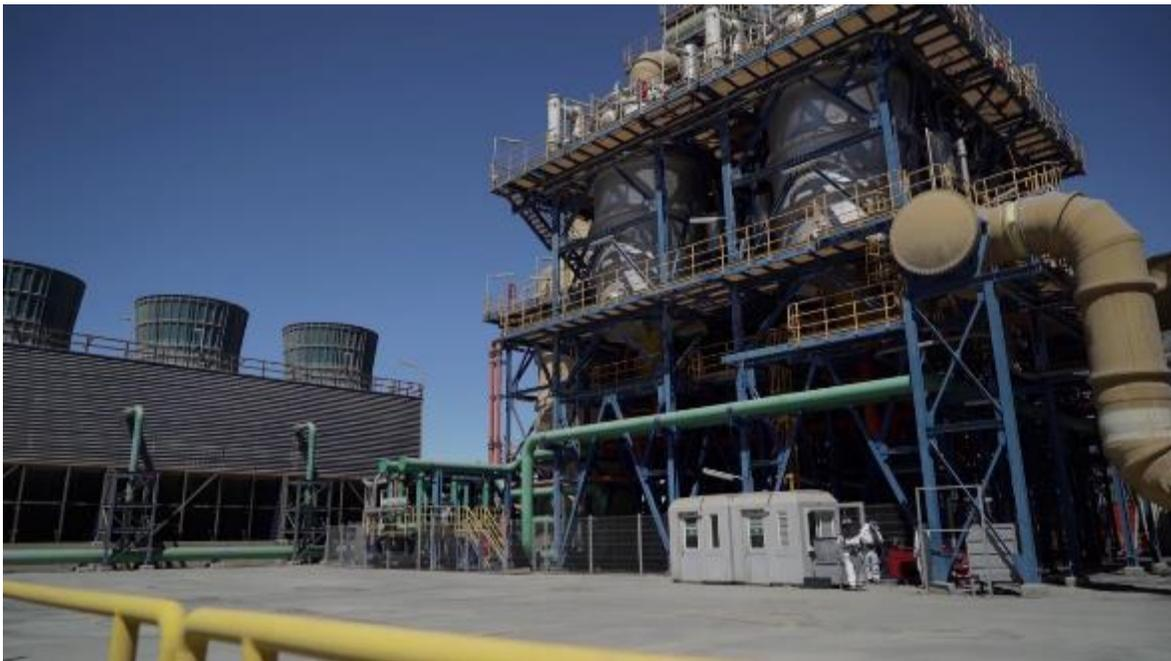
Ilustración 20. Planta de tostación de lecho fluidizado. Fuente: [33]
