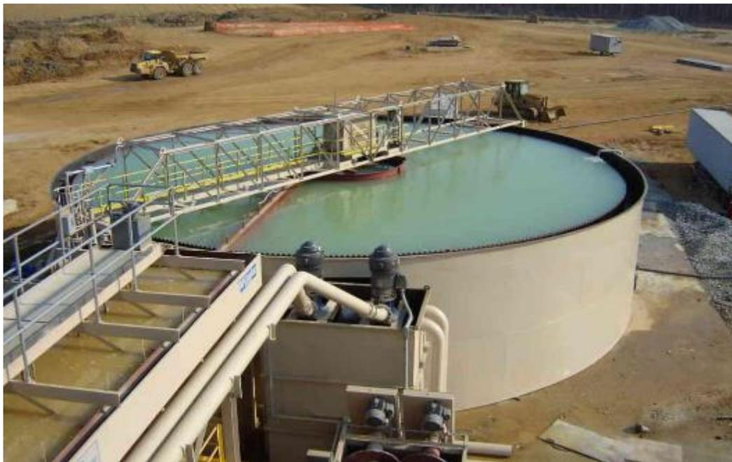
Figura. Espesadores de alta velocidad. Fuente: McLanahan.
