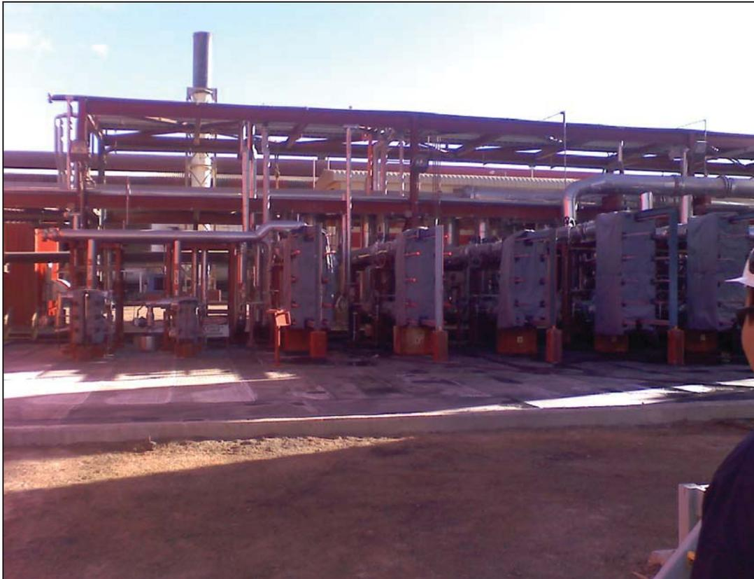
Figura 3.1: Intercambiadores de calor de placas en el patio estanques
