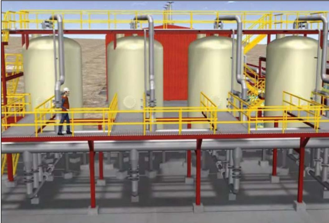
Figura A1.13: Filtros de electrolito utilizados en el PE.
