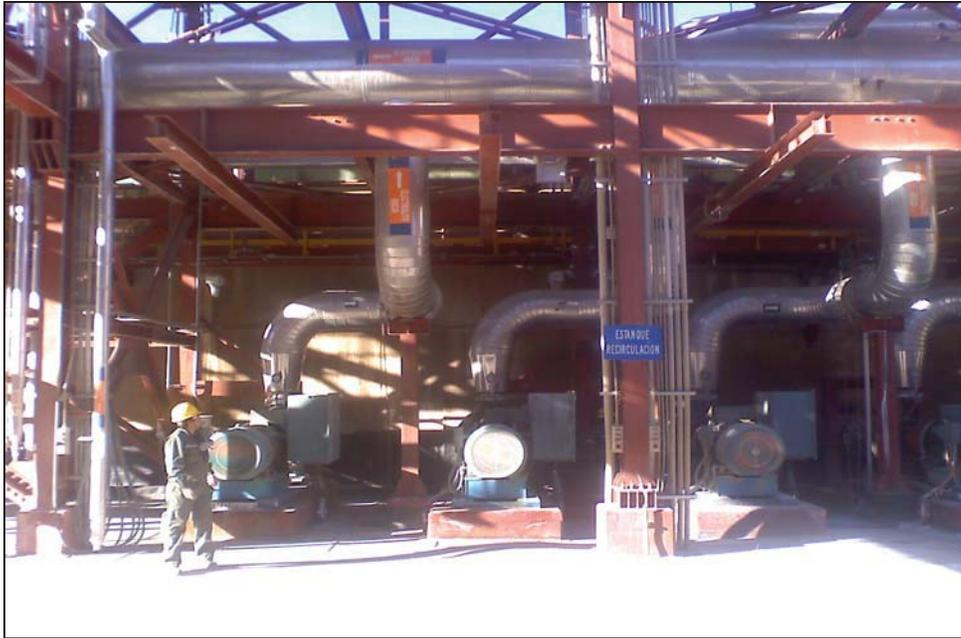
Figura 3.4: Bombas de alimentación a celdas de electroobtención.
