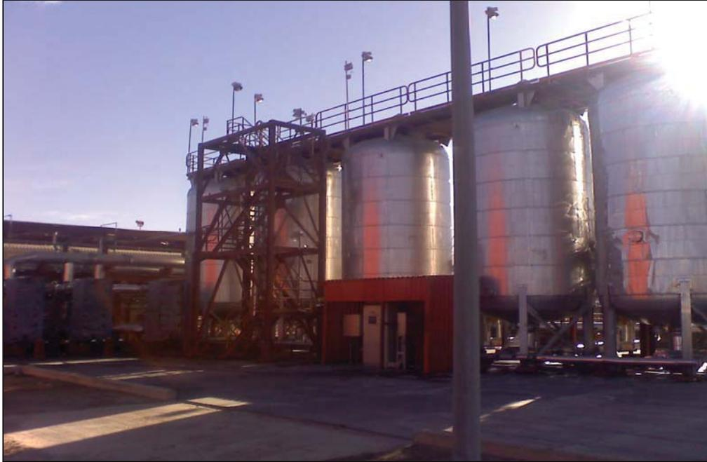
Figura 3.2: Filtros de Electrolito ubicados en el patio estanques de la planta.
