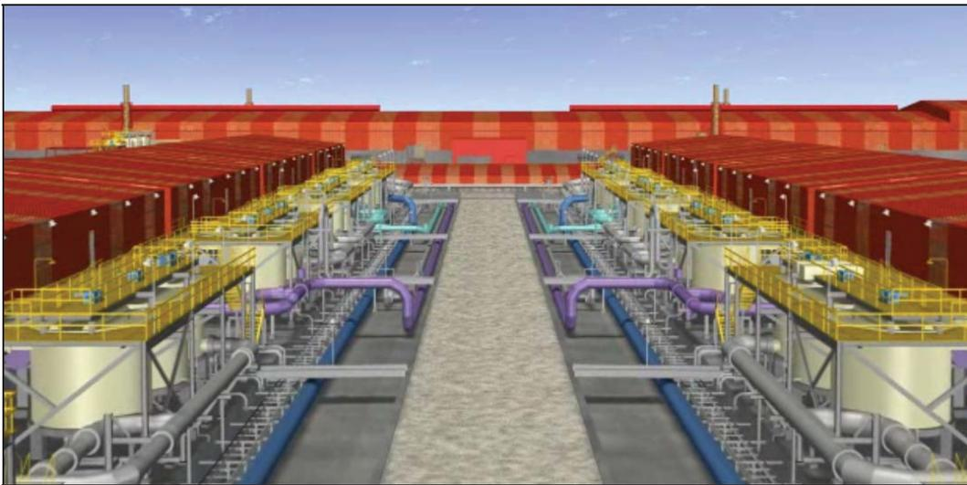
Figura A1.7: Edificios y equipos encargados de realizar la etapa de SX.
