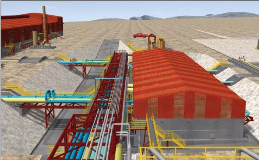
Figura A1.10: El patio estanques está ubicado entre EW y SX. A su izquierda está el edificio de EW y a la derecha está la etapa de SX que no se alcanza a visualizar.
