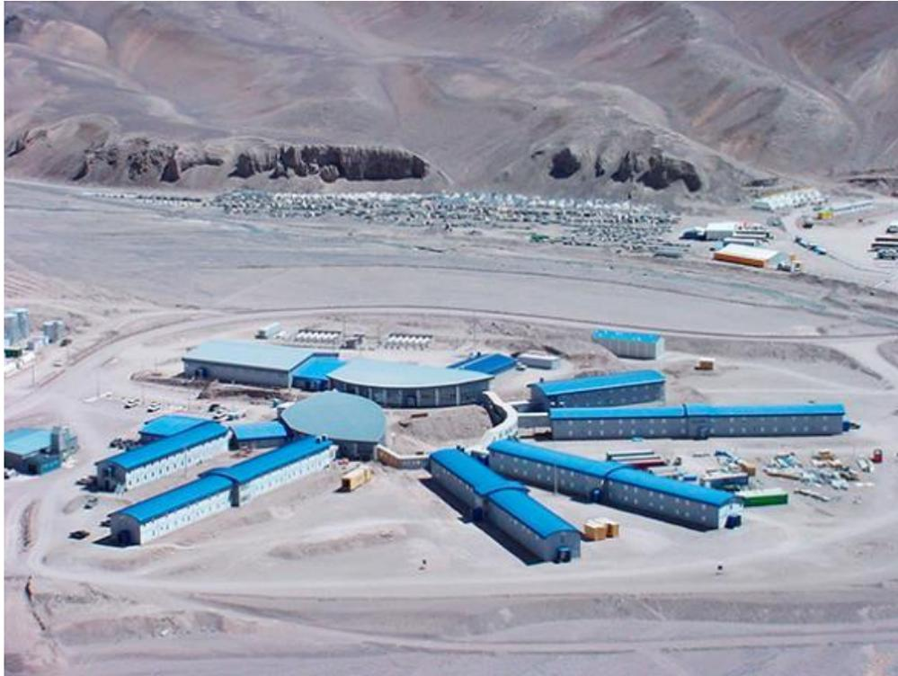
Figura: Campamento en base a sistema modular de construcción. Fuente: Revista Construcción en minería
