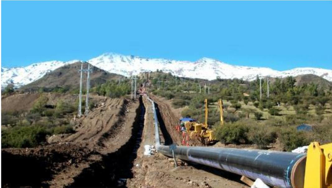
**Figura: Tubería de relave. Fuente: Ausenco**
