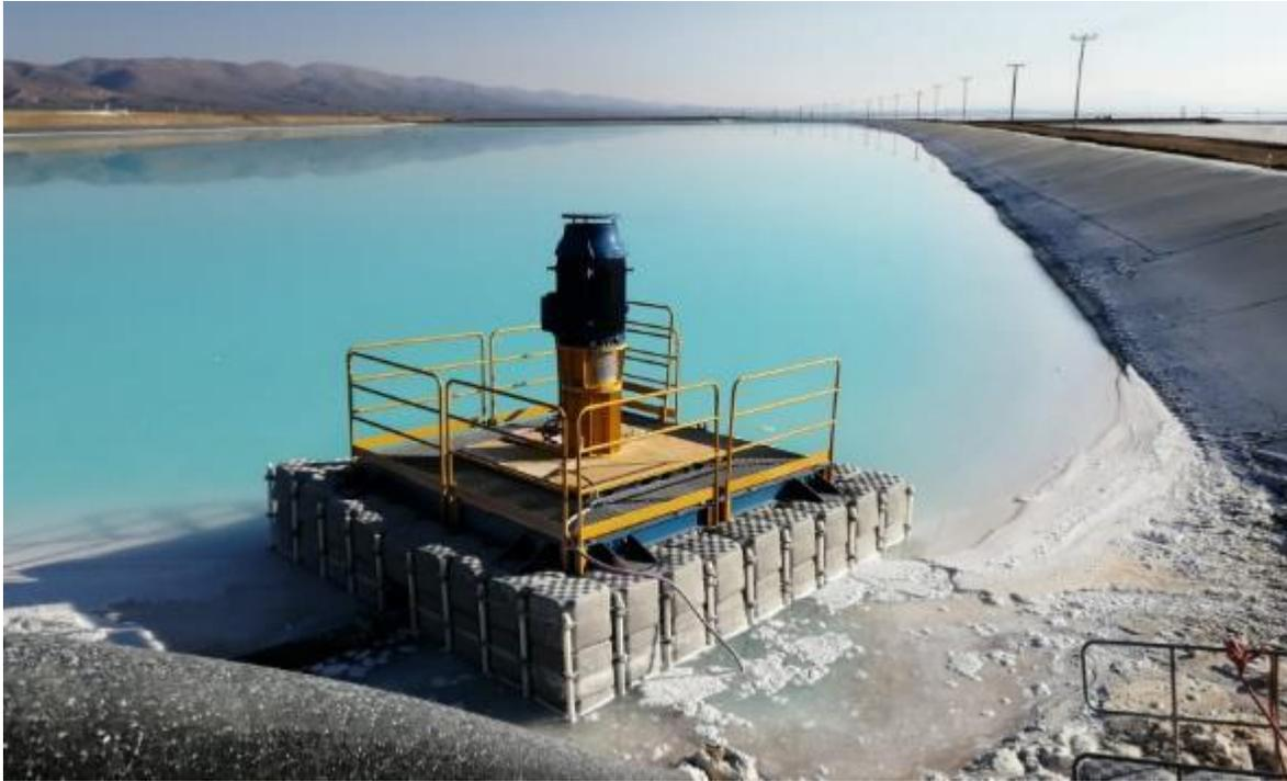
Ilustración 8. Bomba vertical de extracción de salmuera. Fuente: Catálogo Bombas VOGT
