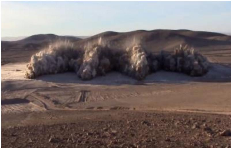
Ilustración 6. Aplicación de tronaduras para extracción de salmuera. Fuente: SQM
