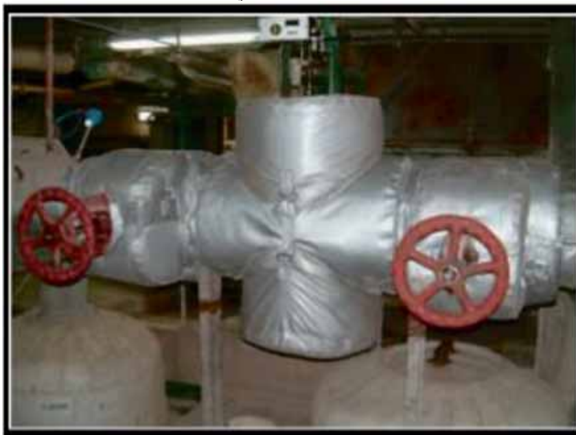
Ilustración 11. Válvula sin y con aislamiento térmico desmontable
